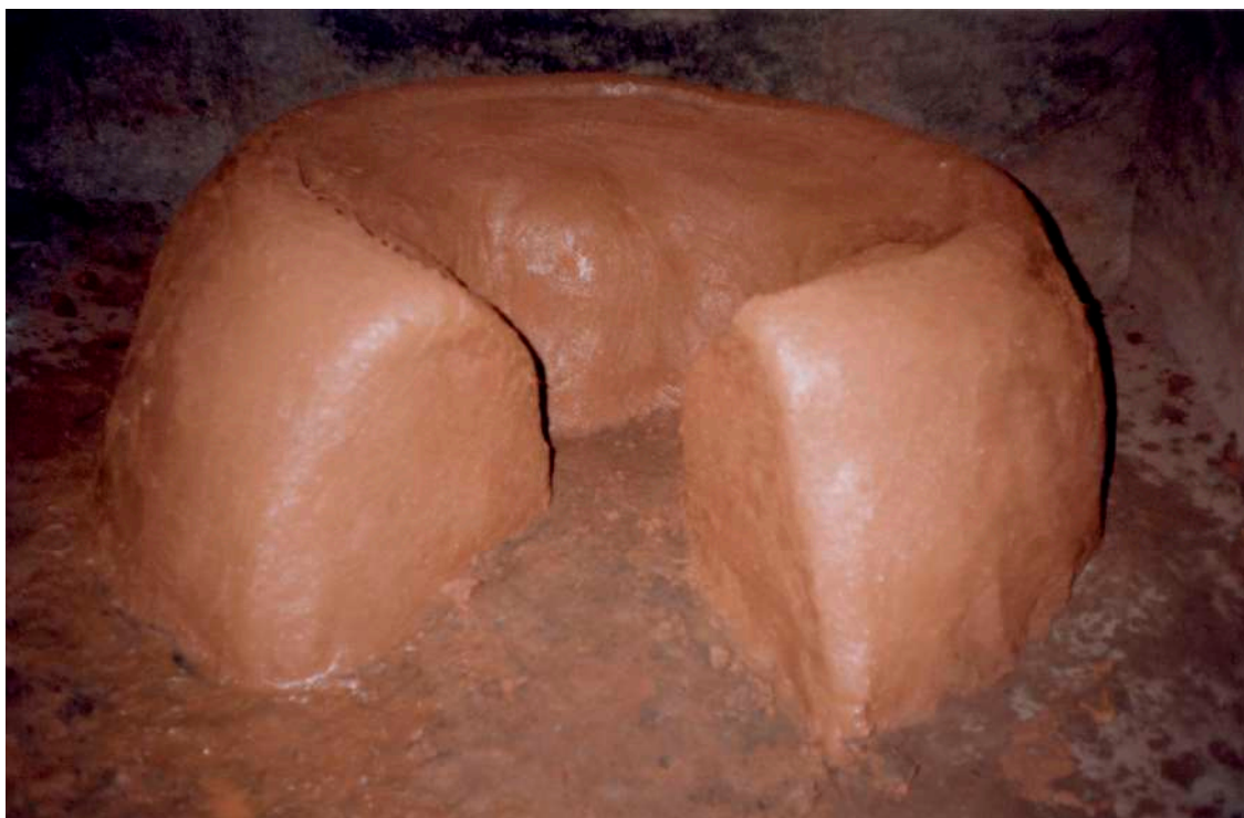
La construction du foyer amélioré est achevée. Il pourra être utilisé dès que séché.
