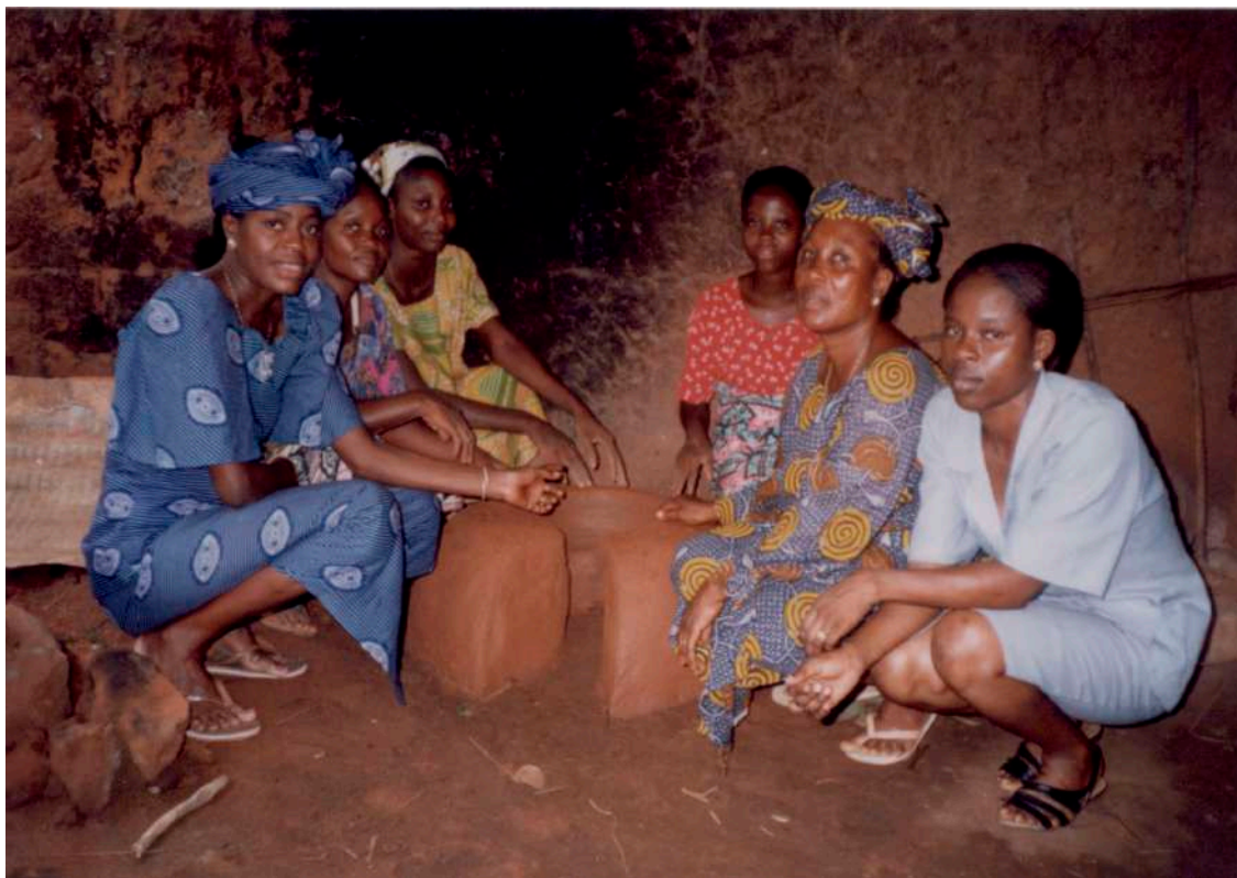
Cette photo montre la construction en cours d'un foyer amélioré.
