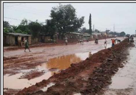
Une vue partielle de la route en préparation.
